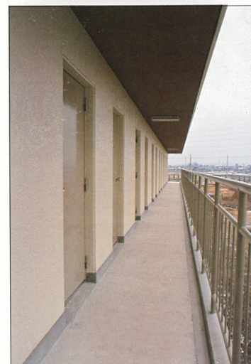
◀ 部室棟 2F 通路
