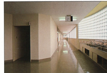
普通教室棟 2F ~ 4F 廊下・手洗 ▲
