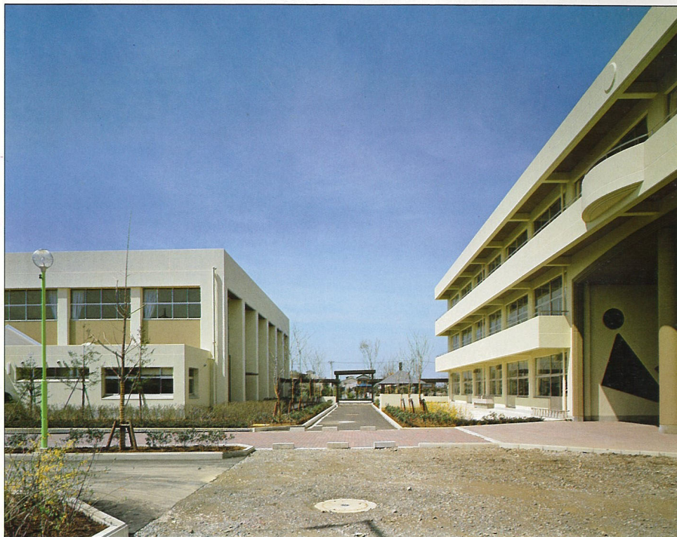
特別教室棟・屋内運動場連絡廊下
